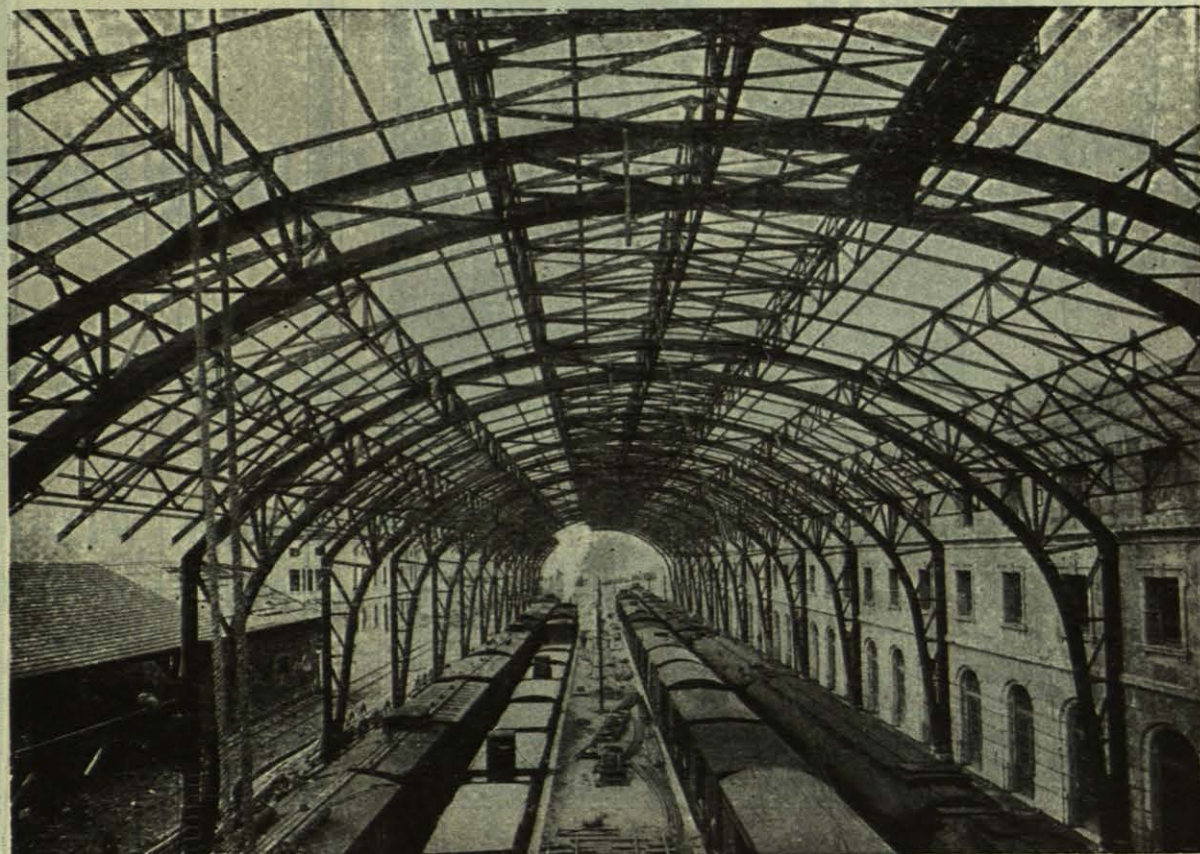
Estación internacional de Port-Bou.—Cubierta de andenes.—Agosto-Diciembre 1928.
