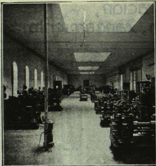
Fábrica de la Moneda y Timbre. Una de las naves pavimentadas con asfalto fundido.
